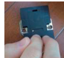
④受をビスで固定し位置決め完了。治具を外して最後にカバーを装着。
