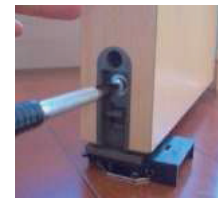
②戸当り位置を決め、ビスを緩めて本体の高さ調整を行う。
