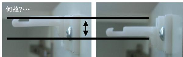
上下2mmの調整機構で自動的に受けが適正位置へ補正されます。
